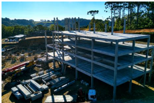
Obras do empreendimento em ritmo acelerado
