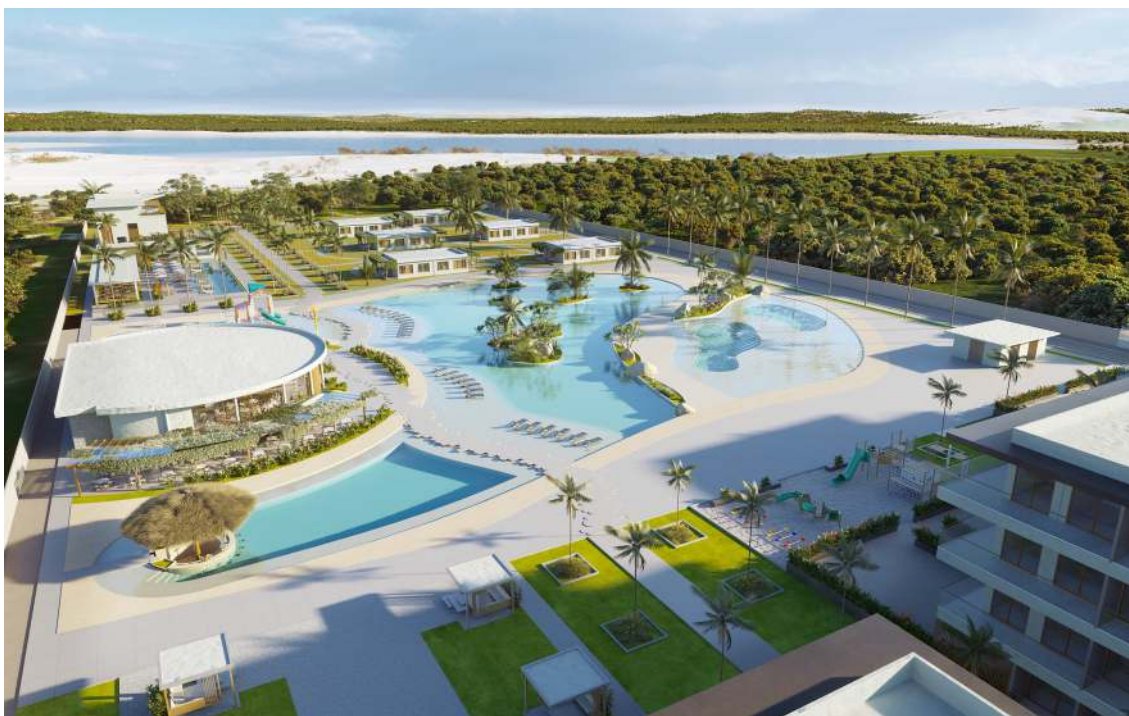
Jeriquiá Lagoa Resort, localizado à beira da Lagoa do Paraíso, no município de Cruz, próximo a Jericoacoara-CE
