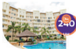
Construção e entrega.
