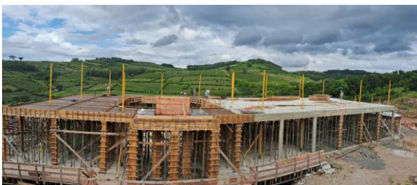
Obras em andamento do Castelo do Vale Resort - Janeiro/2024
