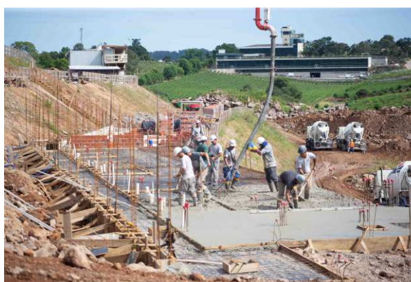
Obras em andamento do Castelo do Vale Resort - Janeiro/2024
