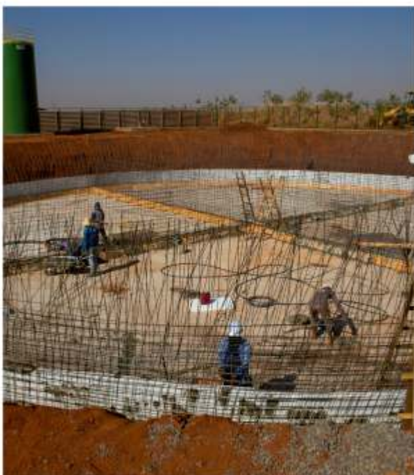
Obras do reservatório de termoacumulação.
