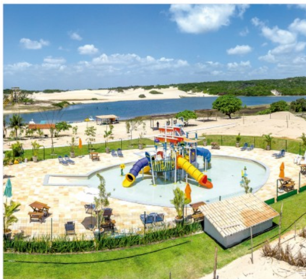
Pitangui Lagoa Park (Extremoz/RN) - construção de novas áreas
