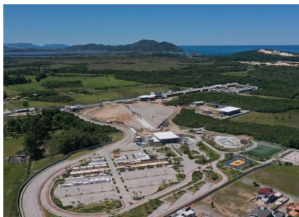
► Foto aérea da construção do empreendimento
